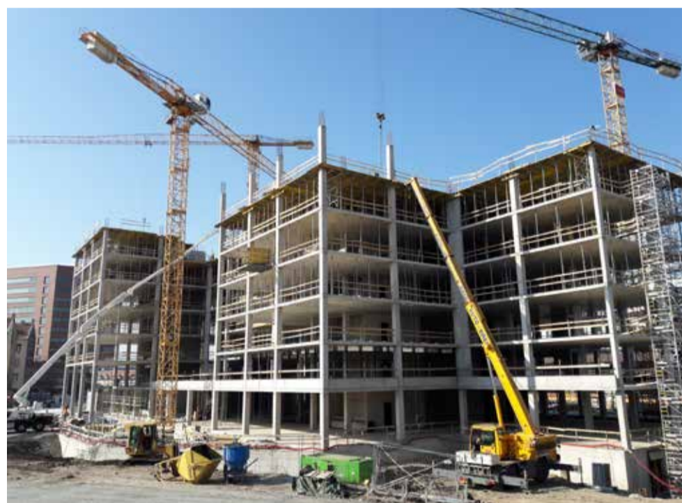
PSG a.s. – Monolitické konstrukce, ukázka realizace střediska
