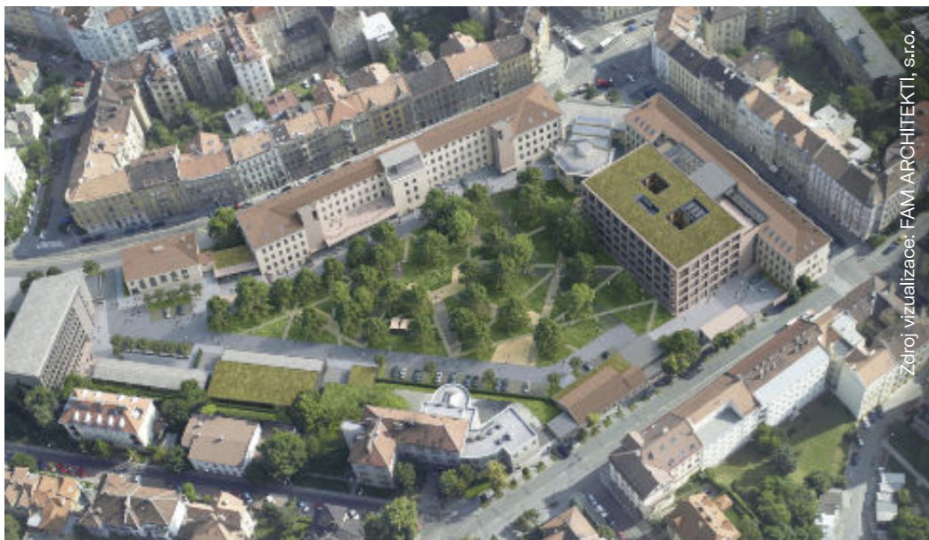
Rekonstrukce a dostavba areálu Údolní 53 VUT v Brně
